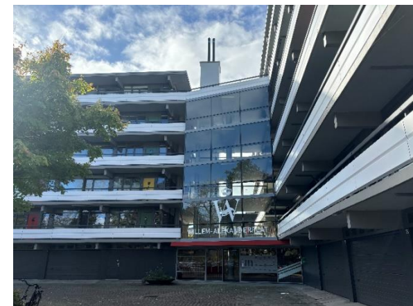
Figuur 1.3 De Willem-Alexanderflat die in 2023 is aangesloten op het warmtenet
