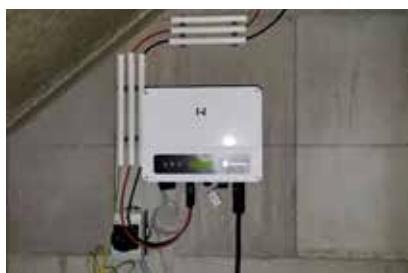
Omvormer zonnepanelen
