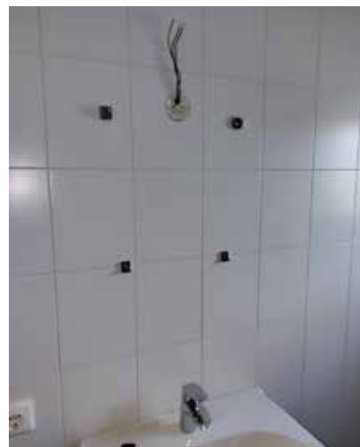
Aansluiting voor verlichting achter spiegel badkamer
